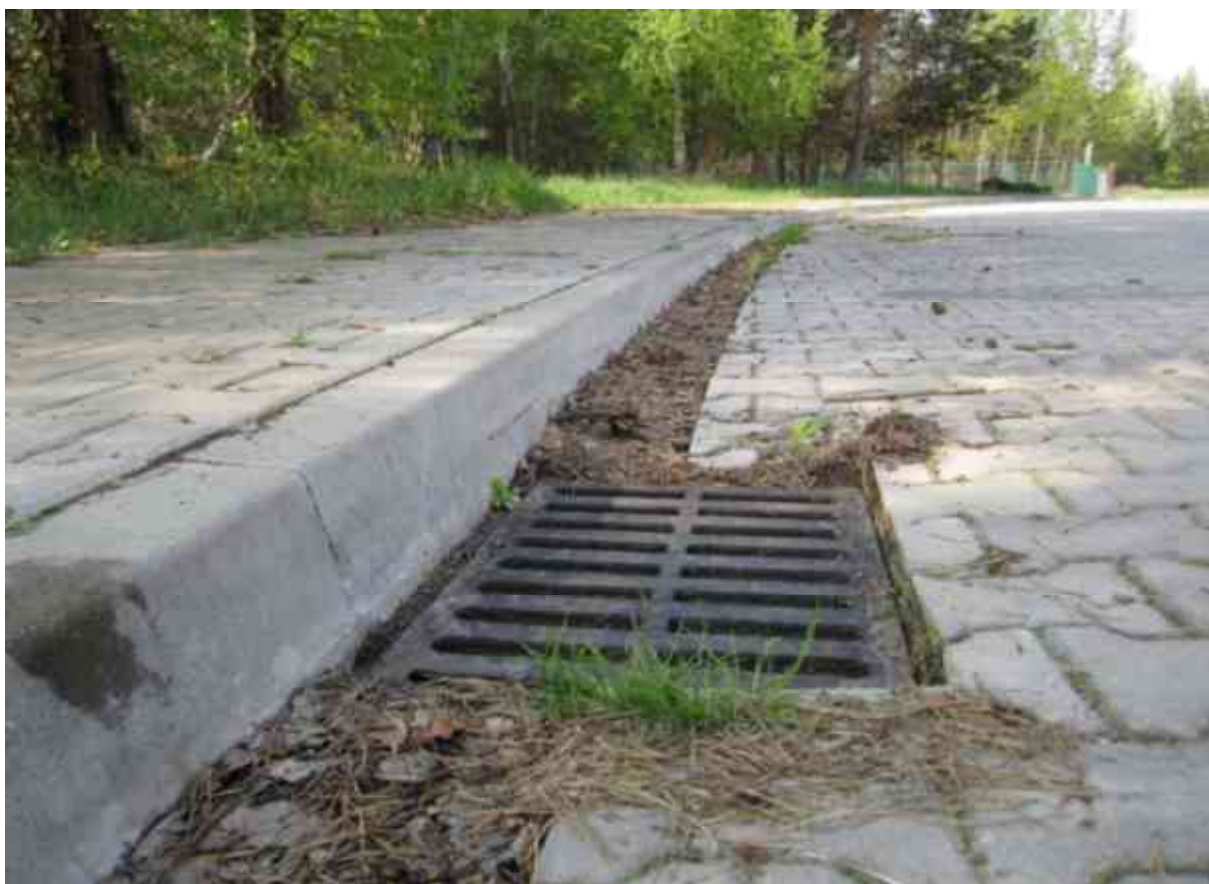
Fot. 230. Studzienka rewizyjna/ściekowa w ul. Grechuty. Wysoki krawężnik, uniemożliwia płazom opuszczenie kostkowej nawierzchni drogi i idealnie naprowadza płazy na studzienkę. (MM)
