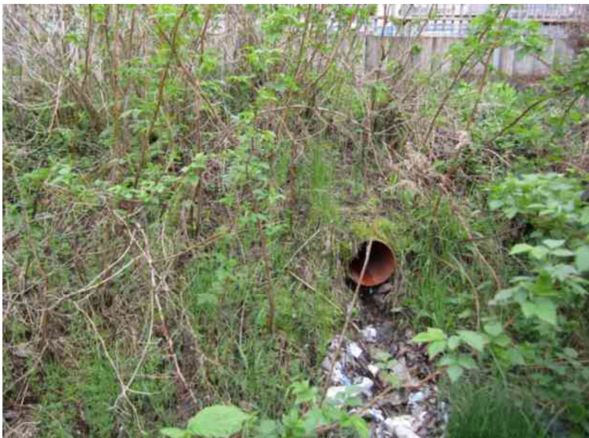
Fot. 253. Ujście rury PCV odprowadzającej wody z terenu zakładu produkcji kruszywa i betonu. (MM)
