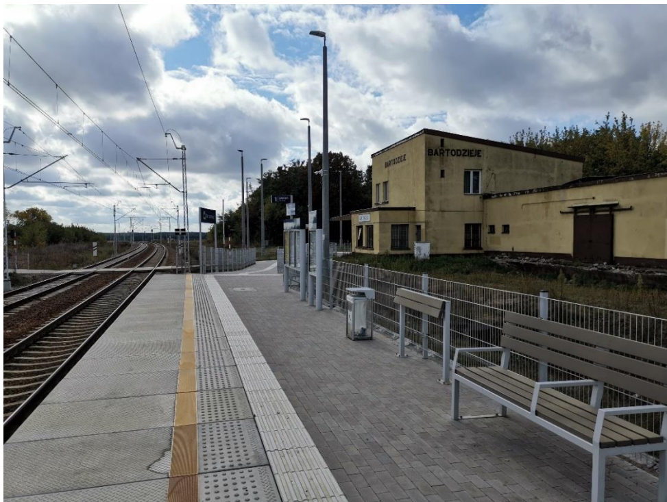
Fot. 4.2 Zmodernizowany przystanek osobowy Bartodzieje
