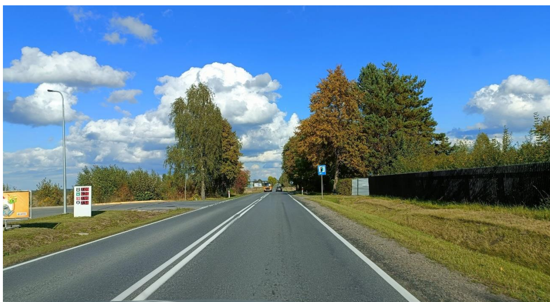
Fot. 4.17 Infrastruktura drogowa na terenie GOFR
