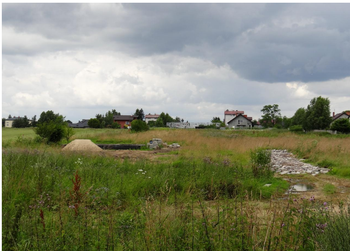
Fot. 87. Budowa na brzegu cieką – obszar południowy (M.M.)
