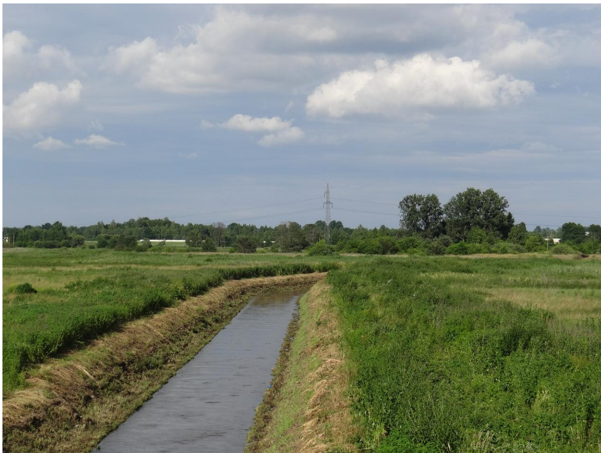
Fot. 80. Prostowanie koryta rzeki i usunięcie drzew w dolinie Mlecznej (M.M.)
