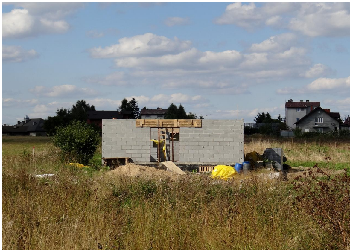
Fot. 86. Budowa na brzegu cieką – obszar południowy (M.M.)
