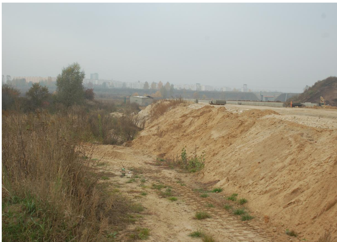
Fot. 68. Nasyp nowobudowanej południowej obwodnicy Radomia (P.J.)
