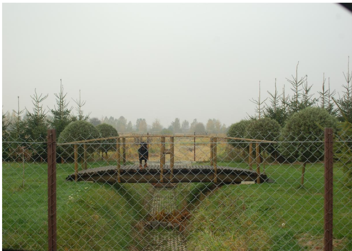
Fot. 81. Rów Malczewski przechodzący przez ogrodzoną posesję (P.J.)
